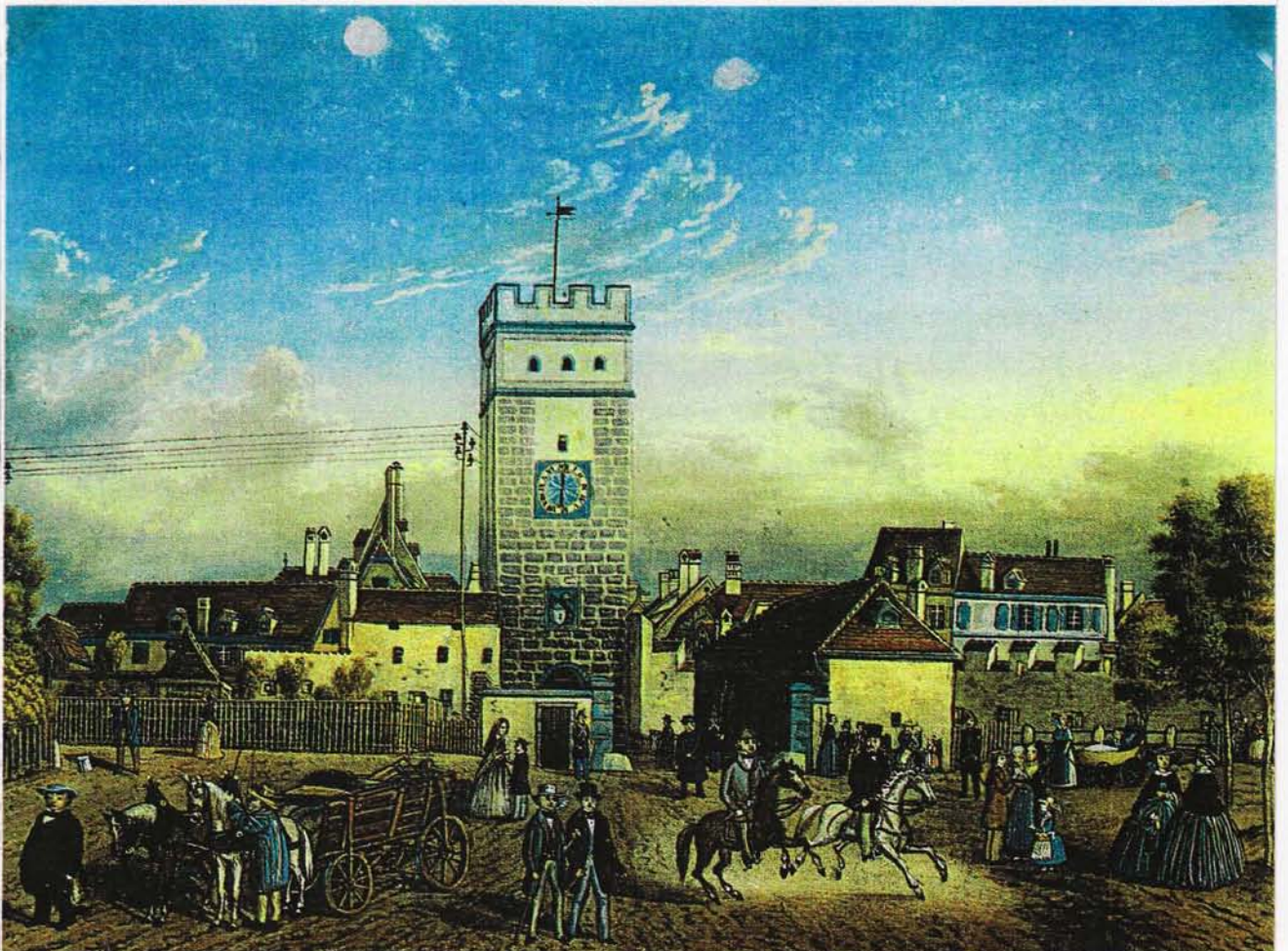
Im Jahre 1858 beginnt die Demontage des Aeschentors, Basels einst bedeutendstem Eingangstor vom Jura her. Denn der Bau des Centralbahnhofs fordert den Abbruch des äussern Zollhäuschens, das Auffüllen des Stadtgrabens und das Niederlegen des Aeschentollwerks. Obwohl sich das Baukollegium mutig für die Bewahrung des noch erhaltenen Hauptbaus einsetzt, wird dieser «aus verkehrstechnischen Gründen» am 31. Mai 1861 abgerissen. Aquarell von Louis Dubois. 1858.
