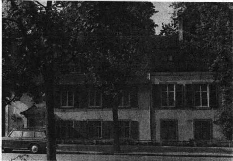
Landhaus zum Singer, Abbruch bevorstehend (Foto U. Rostetter)
